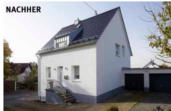
Trotz Aufsparrendämmung (BauderPIR 160 mm): Die Aufbauhöhe des Daches bleibt nahezu gleich
